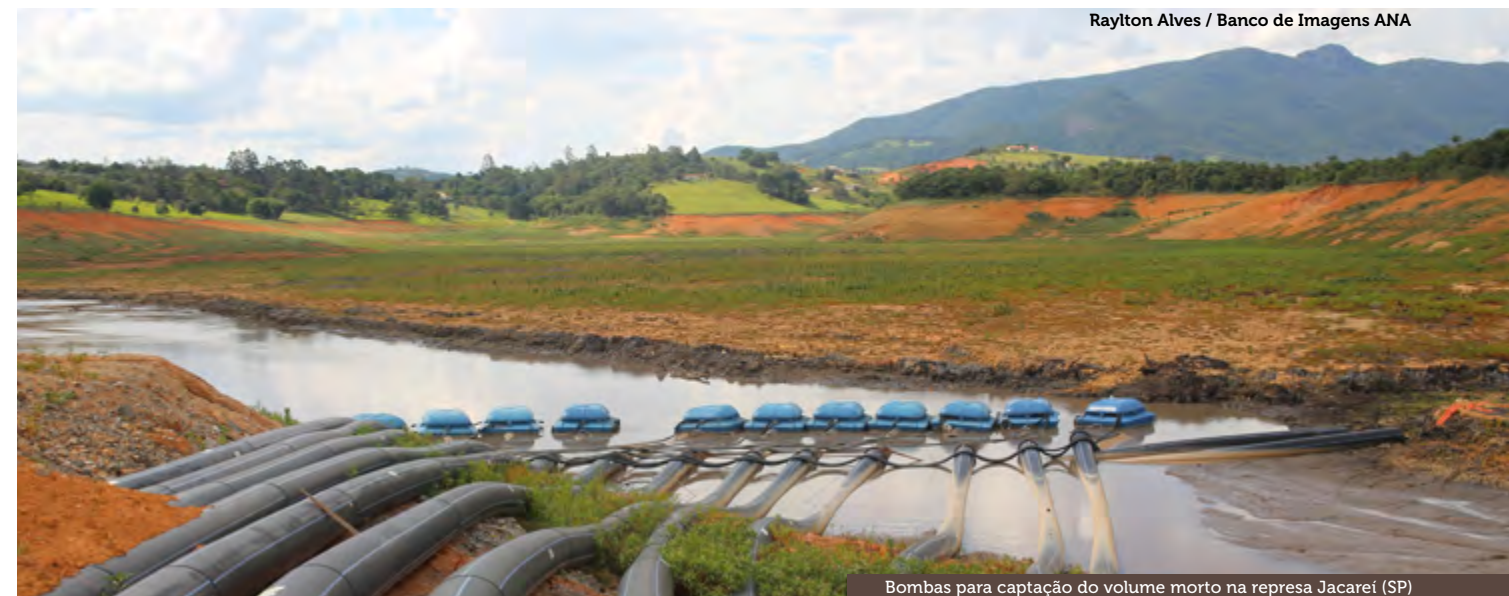
Bombas para captação do volume morto na represa Jacaréi (SP)
